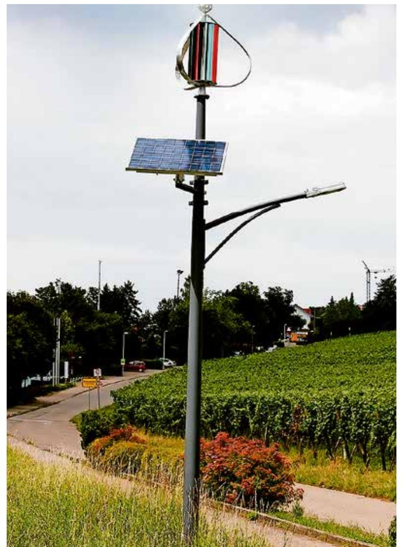
Die LED-Hybrid Straßenlampe kombiniert Windenergie mit Sonnenenergie. Foto: NICMA
